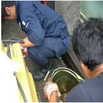
防油堤に流れた油類の汲取り作業
